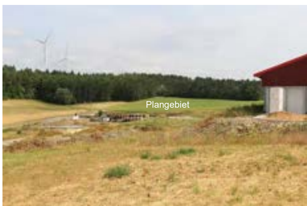
5) Putenstall, Plangebiet mit Baustelle und Lagerfläche © Klärle GmbH, 19.6.2023
