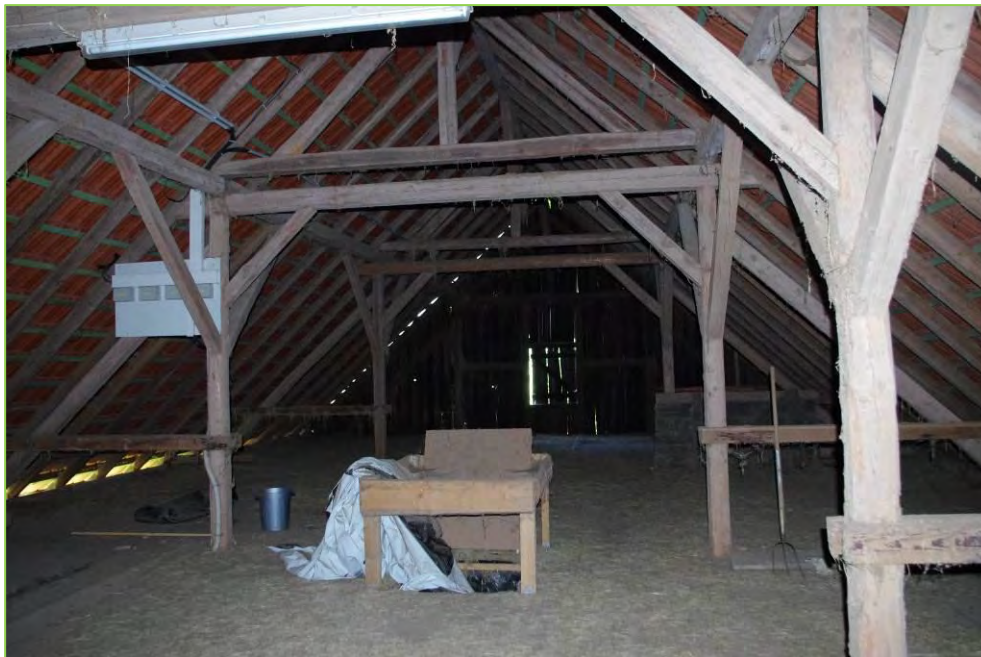
Abb. 11: Potentielle Quartierstrukturen im Dachstuhl
