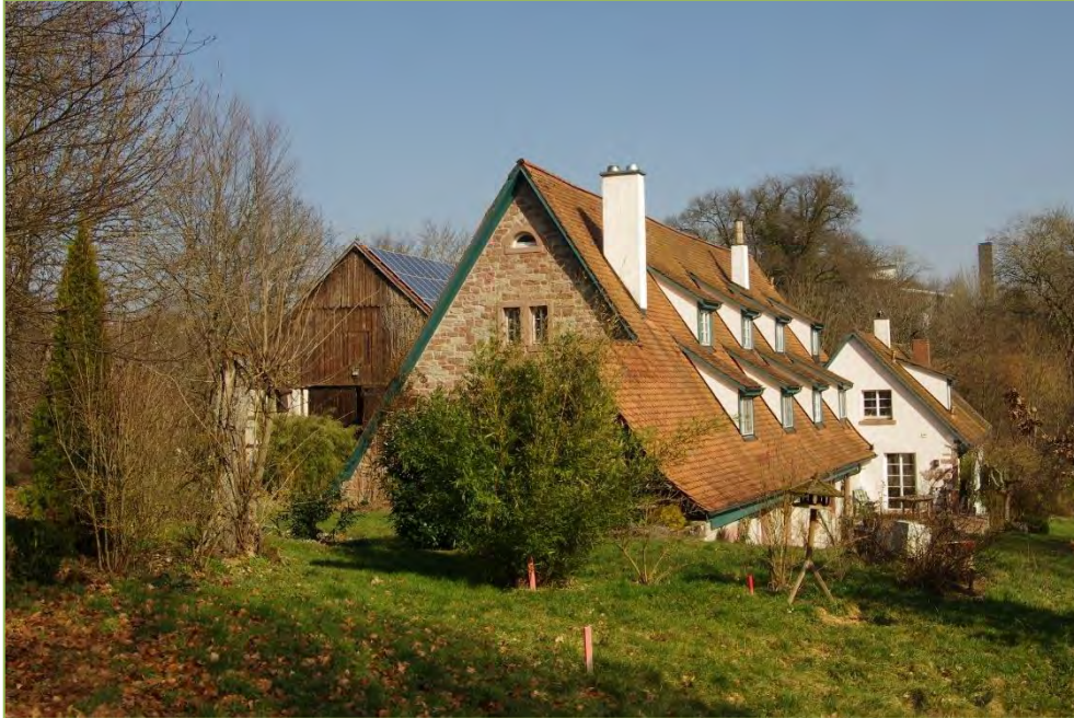
Abb. 4: Hauptgebäude der ehem. Mühle mit Nebengebäude (r.) und Scheune mit Holzgiebel im HG (l.)
