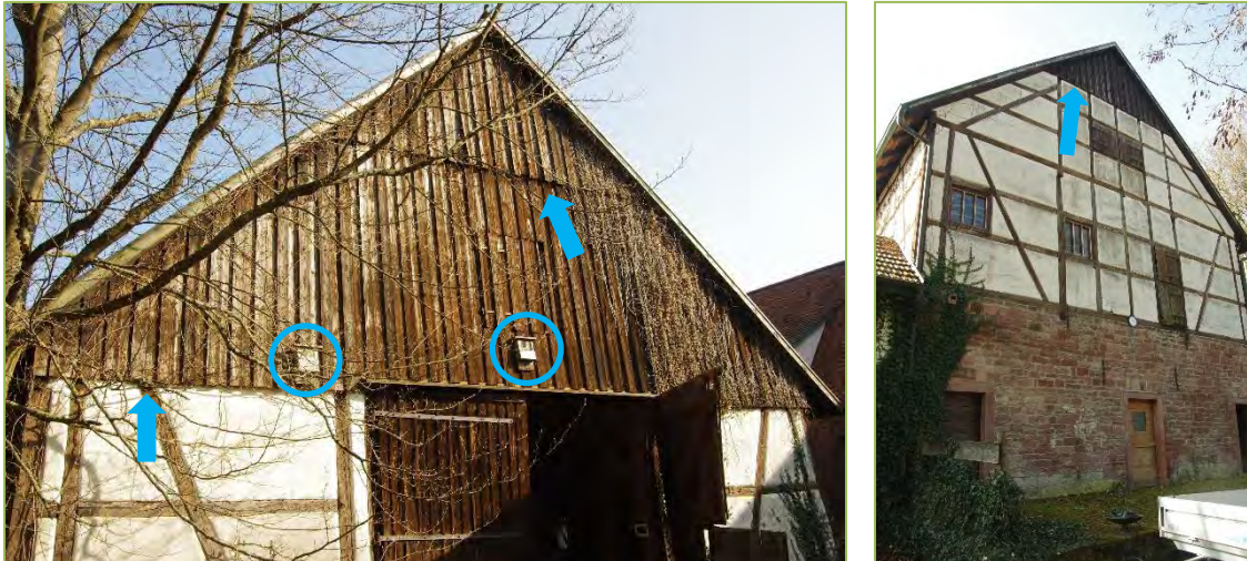
Abb. 10: Potentielle Quartierstrukturen an der Scheune
